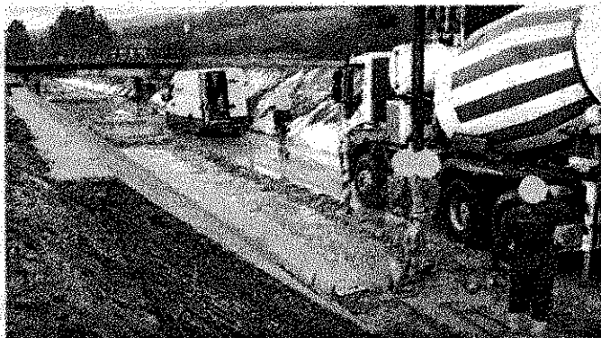
Interventi nei canali artificiali in asciutta
