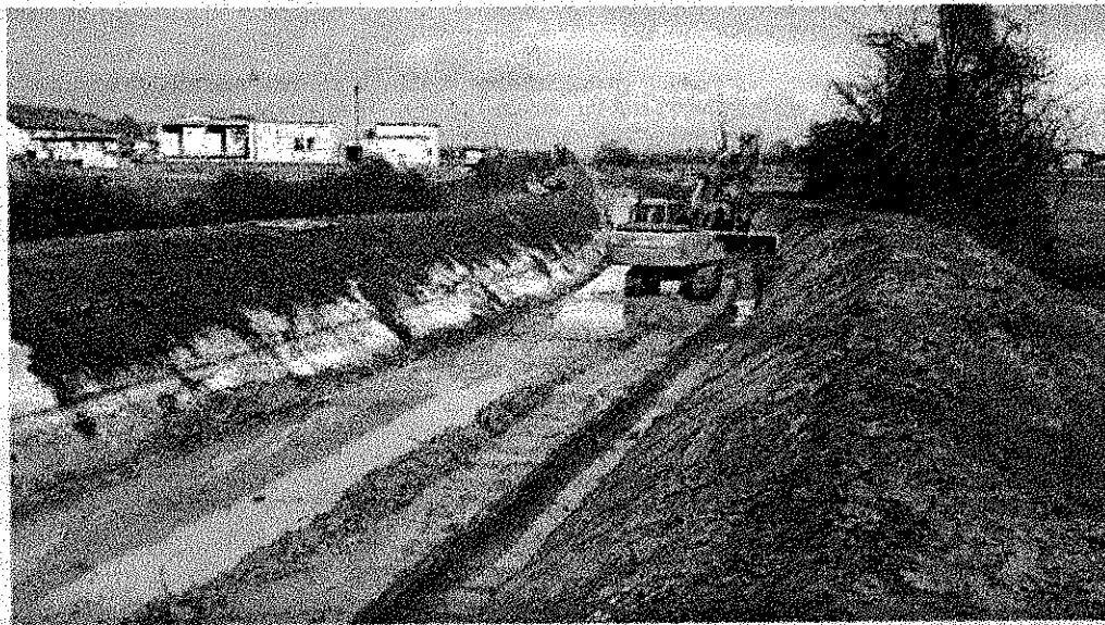
Interventi di manutenzione lungo i canali
